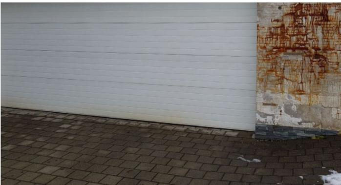
In exponierter Lage verliert der Flex-Klebemörtel die Haftung zum Untergrund durch Einwirkung von Wärme, Wasser und Frost.
