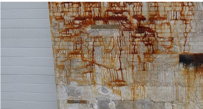
Ganzflächige Ablösung der Fassade trotz massiver Betonwände durch Frostaufbruch.
